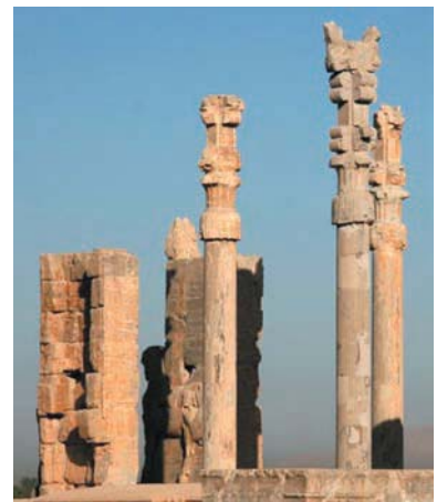
Колонны дворца в Персеполе. Общий вид
